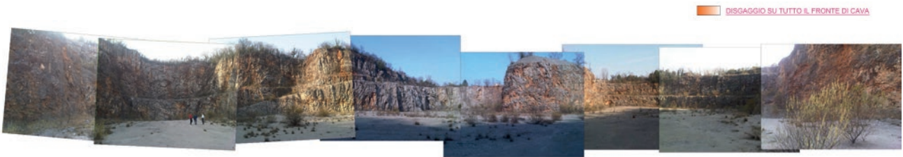
DISGAGGIO SU TUTTO IL FRONTE DI CAVA
